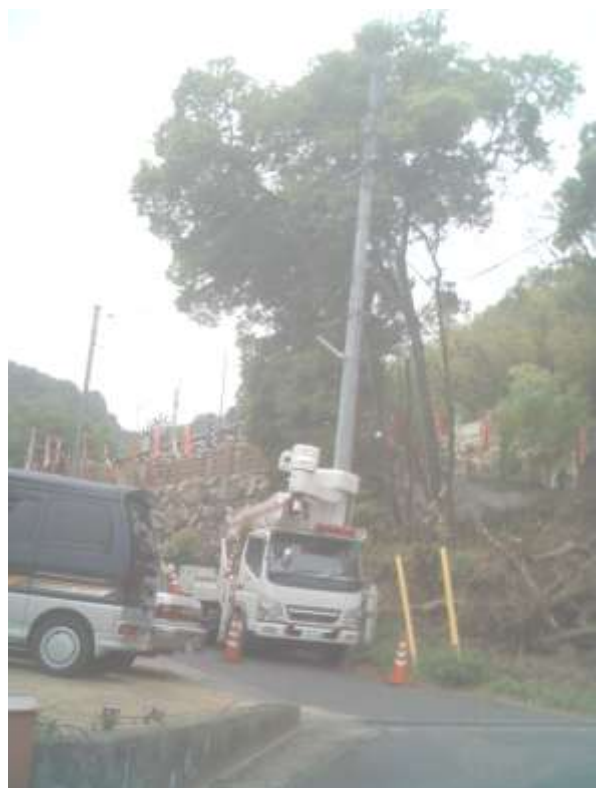
中電による架空電線上の枝伐採風景
